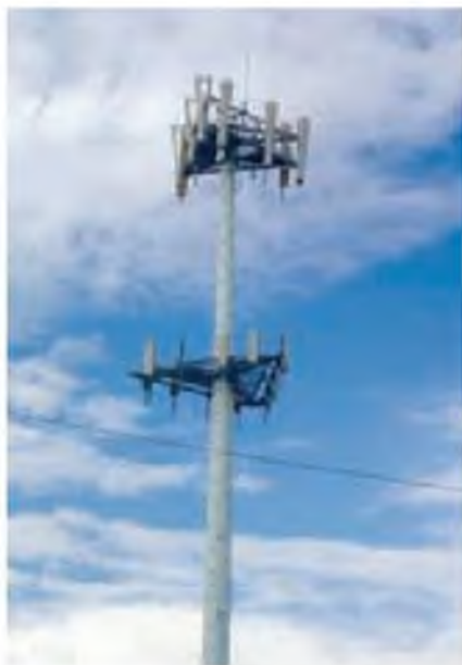
▲ Figura 12.21 Torre para comunicaciones inalámbrica. Las torres como ésta permiten la comunicación a través de los teléfonos celulares.
